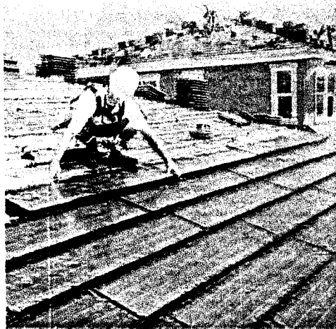
Pannelli fotovoltaici: il Piano punta sul sviluppo delle energie rinnovabili
